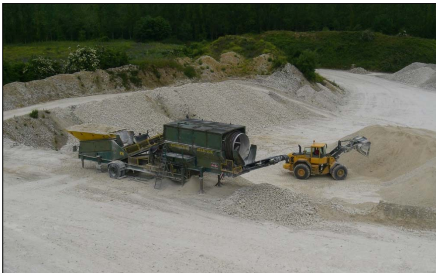
Vue sur une installation de criblage (carrière CABC de Fresnes-Mazancourt)
